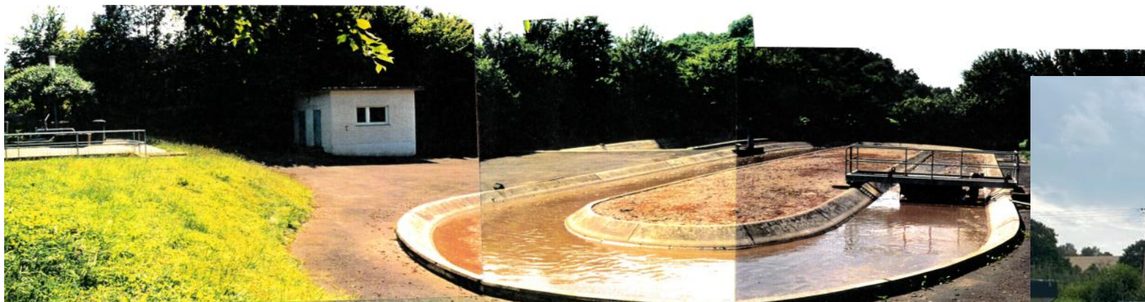
Foto: AWW Ulmen, von 1974 Kläranlage
