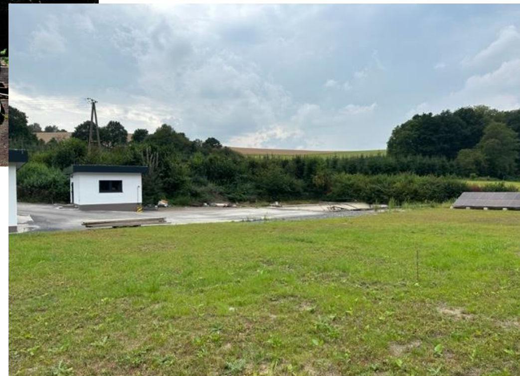
Foto: AWW Ulmen, 2023 Pumpwerk
